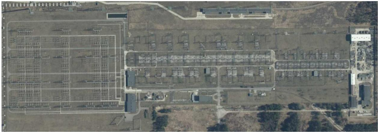
图23 科济涅茨变电站 错误！无法找到引用来源。
