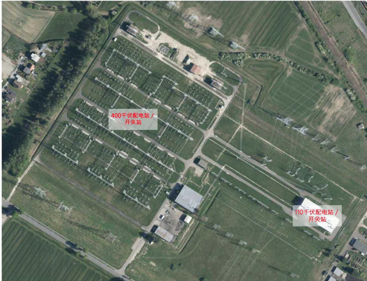
图18 多布热恩变电站
