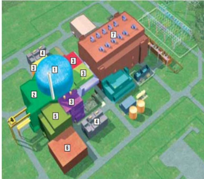
Rysunek 25 Rozmieszczenie głównych instalacji bloku jądrowego EPR
