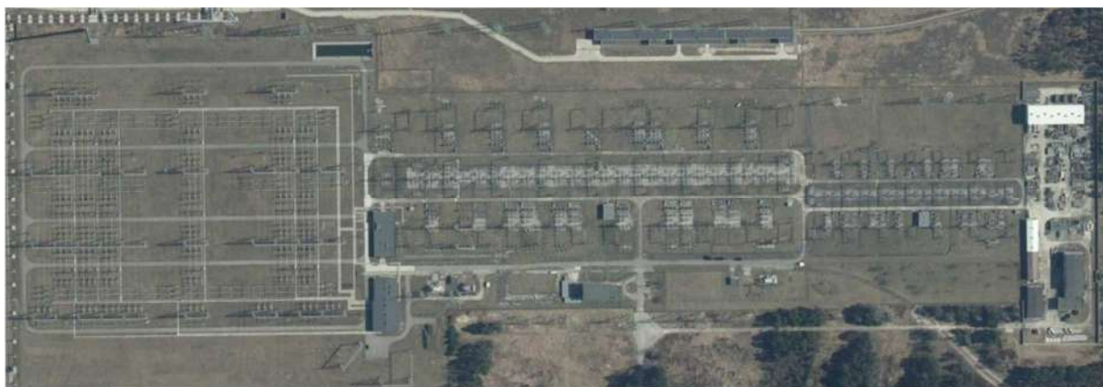
Rysunek 23 Stacja Elektroenergetyczna Kozienice Błąd! Nie można odnaleźć źródła odwołania.
