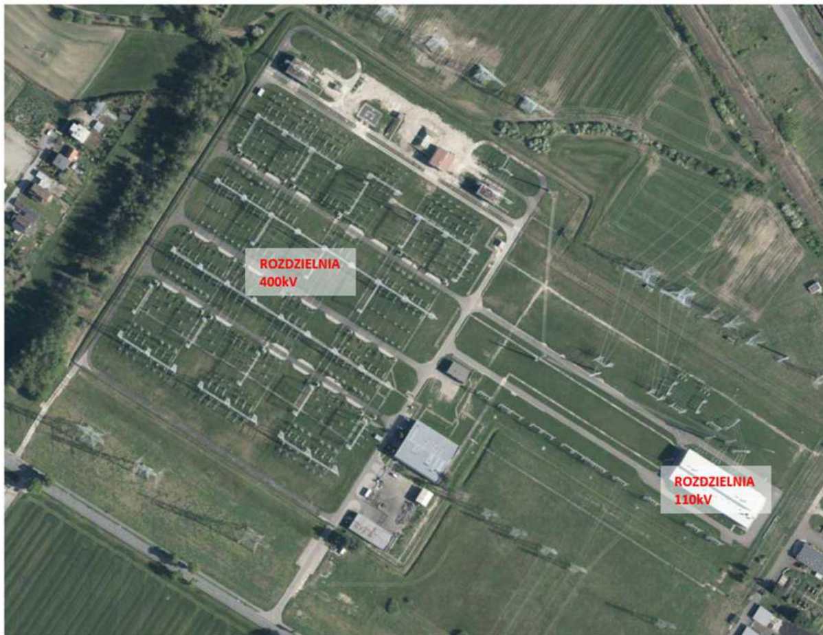
Rysunek 18 Stacja Elektroenergetyczna Dobrzeń
